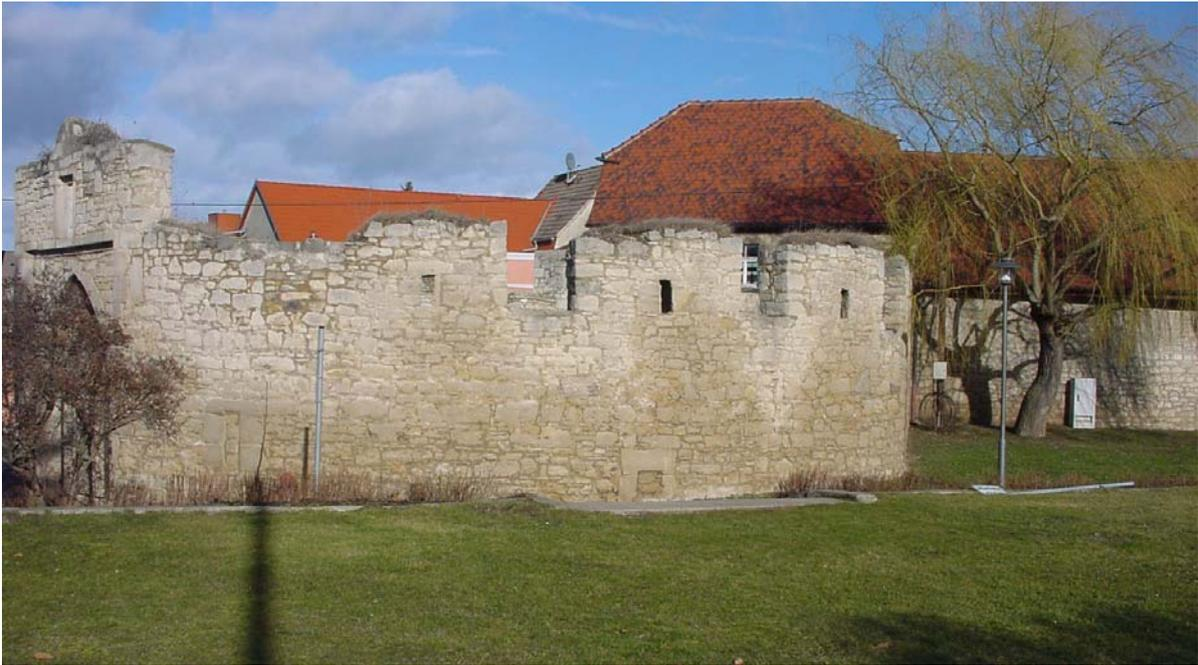
Abb. 22: Laucha. Gebogene Zwingermauer des Obertores von der Feldseite. Gut erkennbar sind diverse Schieß- und Zinnenscharten, die später zugesetzt wurden.
