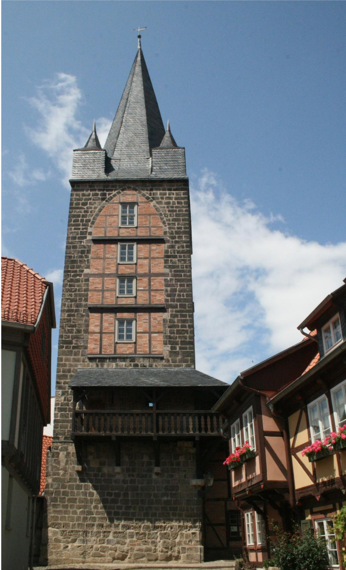
Abb. 18: Quedlinburg. Schreckensturm. Die ursprünglich offene Stadtseite wurde später mit Fachwerk zugesetzt.
