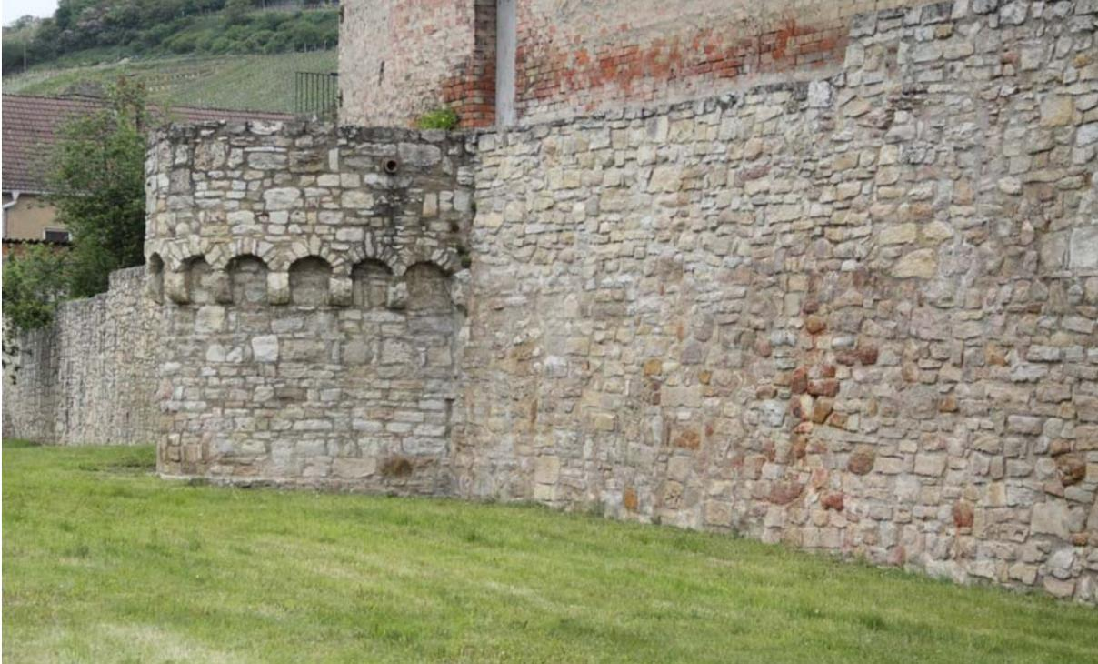
Abb. 29: Freyburg. Turm an den Eckstädter Gärten. Im Gegensatz zu allen anderen erhaltenen Türmen weist er einen Rundbogenfries als Substruktion der Brüstung auf.
