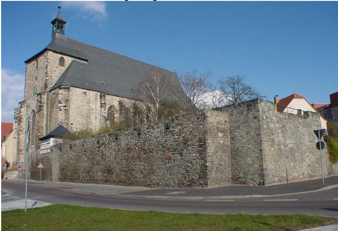
Abb. 9: Halle, Moritzwinger. Die südliche Seite der Bastion ist ein Ergebnis der Denkmalpflege aus den 1920er Jahren. Sie wurde nach verkehrsbedingtem Abriss neu aufgebaut.
