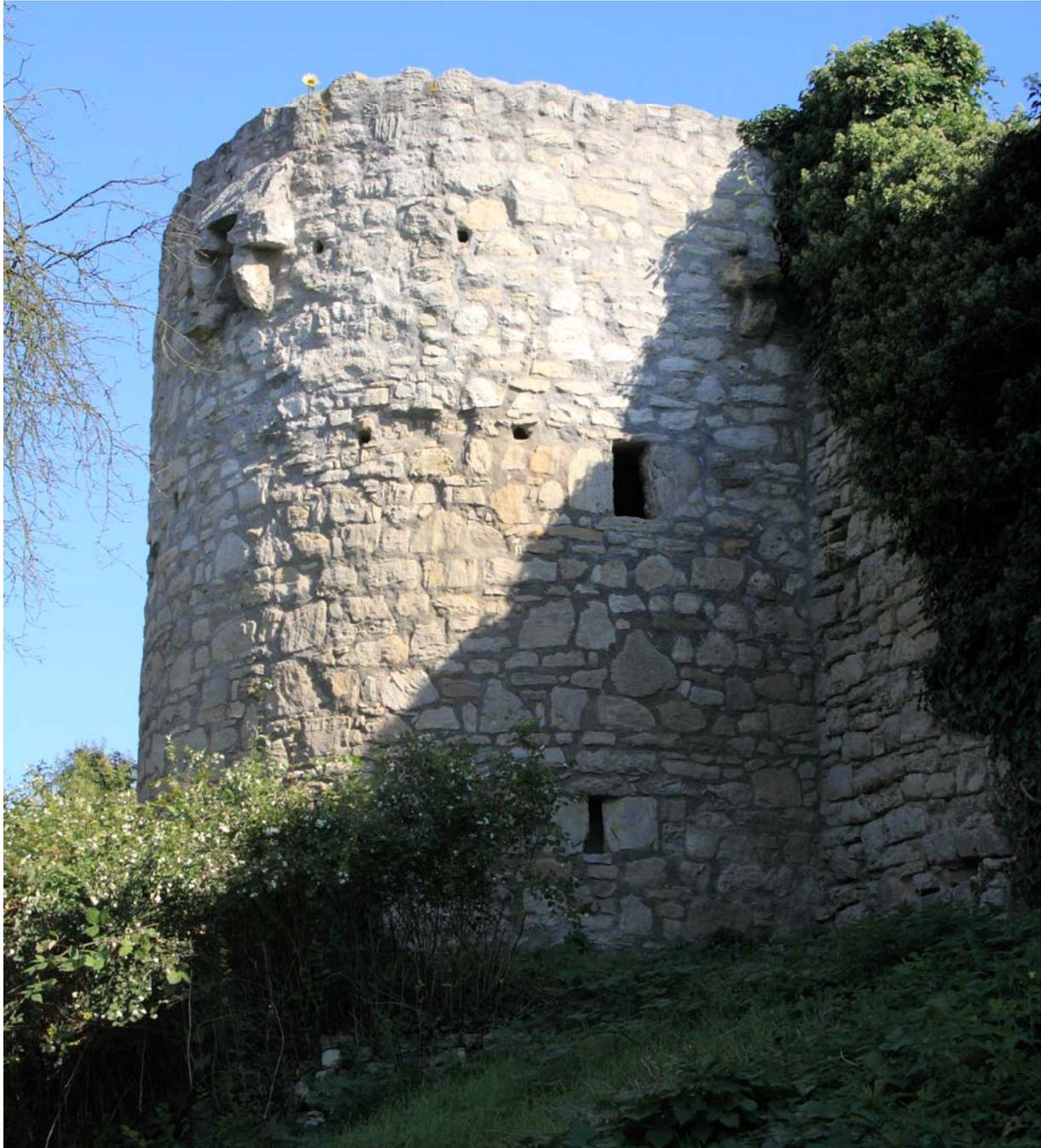
Abb. 27: Freiburg. Turm mit einer maschikuliartigen Schießscharte an der Eckstädter Straße.
